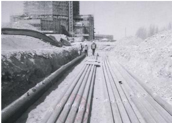
雨水排水管安装
