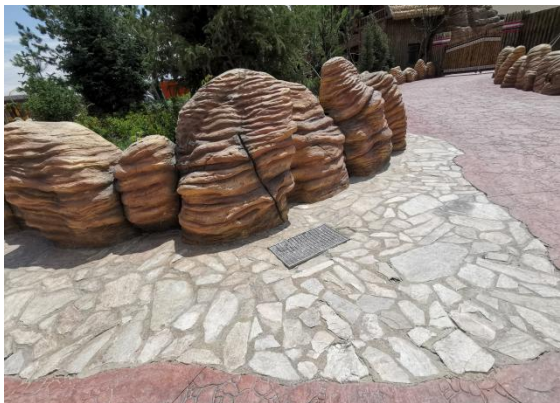
区域内雨水排水井
