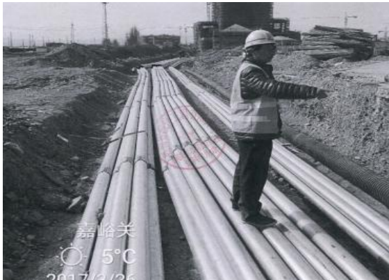
雨水排水管安装
