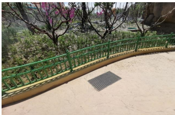
主题园区污水排水井
