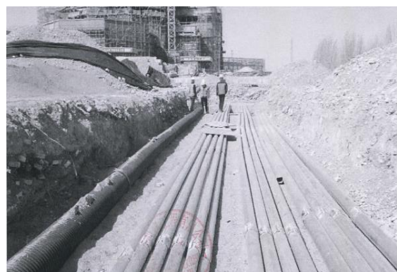
雨水排水管施工
