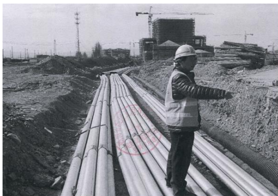
雨水排水管施工
