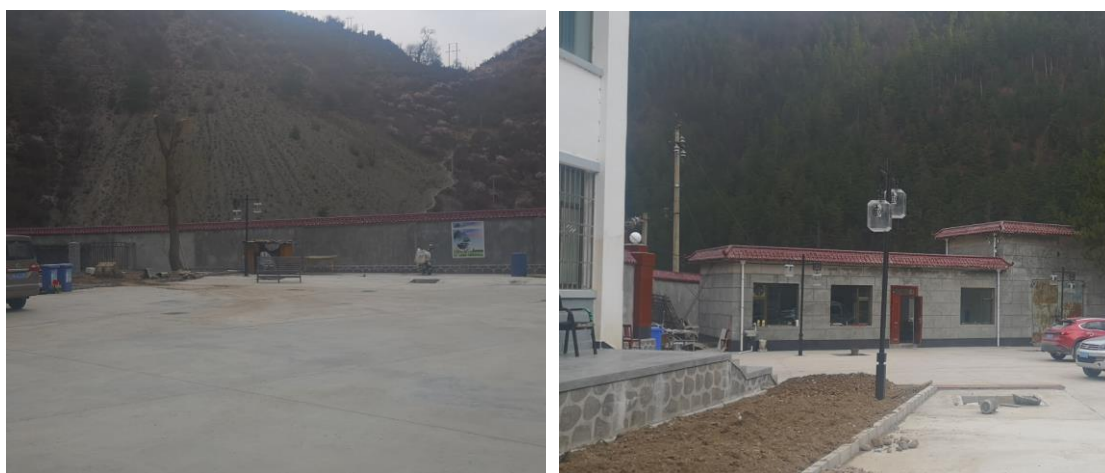
生活垃圾收集设施
