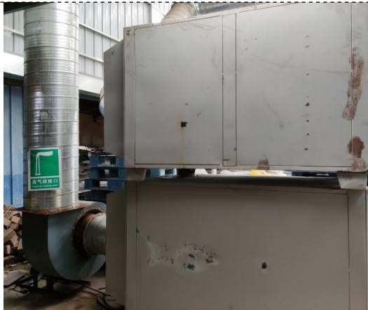
风机减震基础
