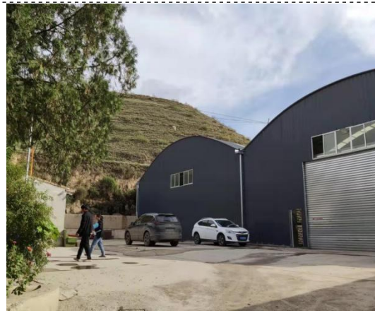
全封闭生产厂房
