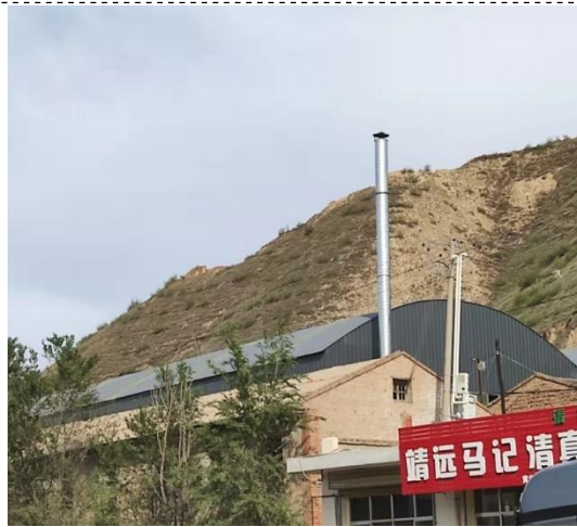
15m 高排气筒
