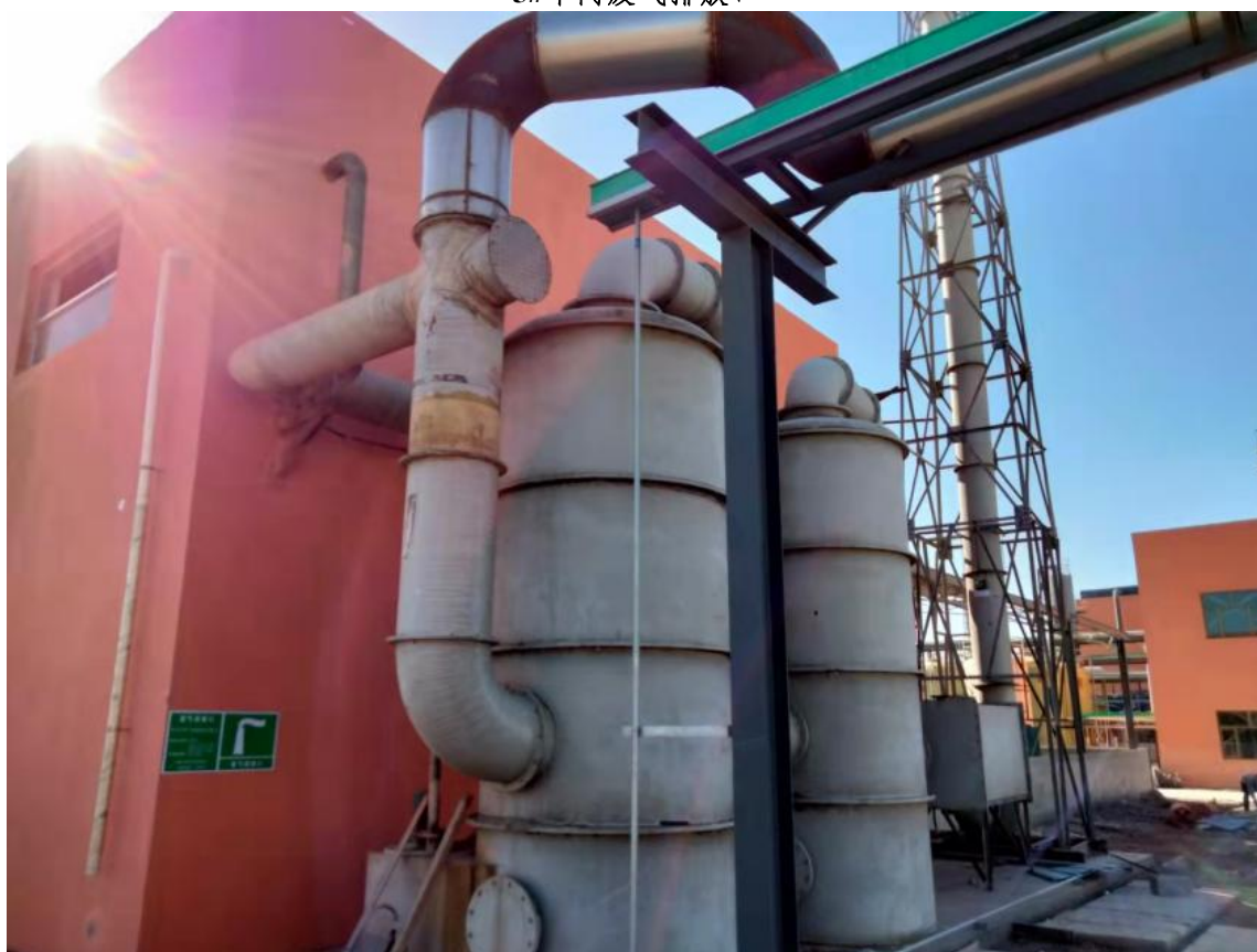
污水处理站“二级碱喷淋+活性炭吸附”废气处理装置
