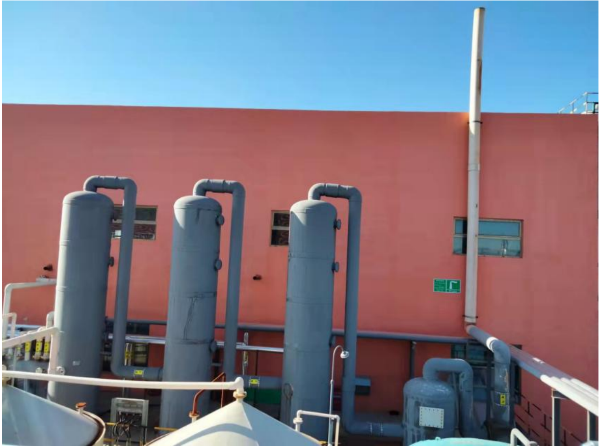
1#车间“三级水喷淋+活性炭吸附”废气处理设施
