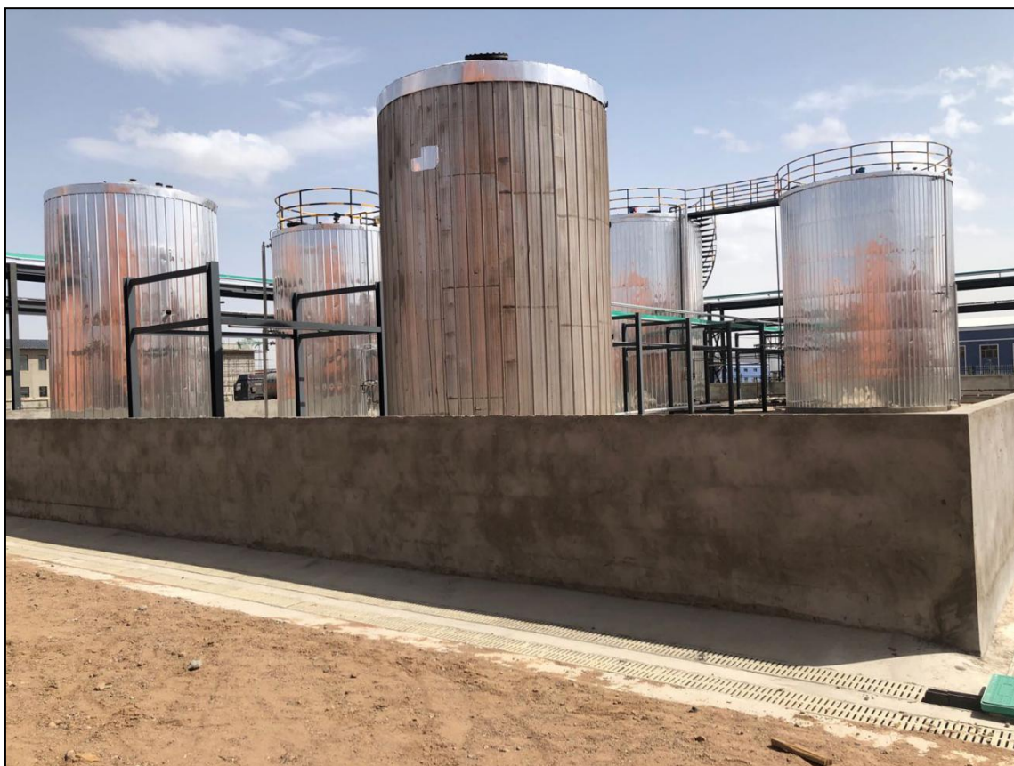
储罐区及围堰 1
