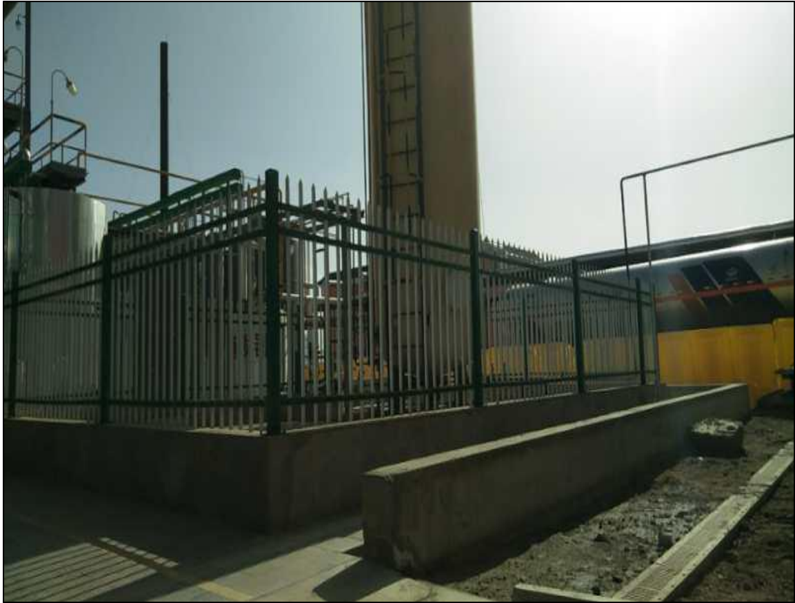
储罐区及围堰 2
