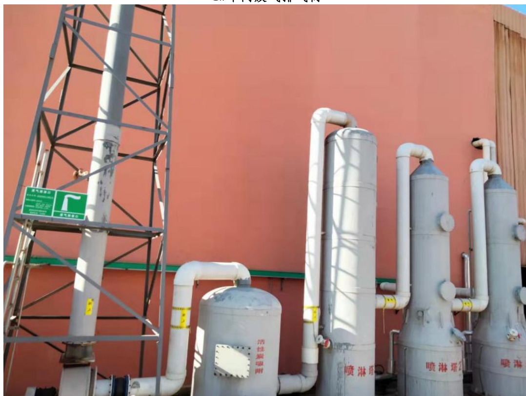
5#车间“三级水喷淋+活性炭”废气处理装置
