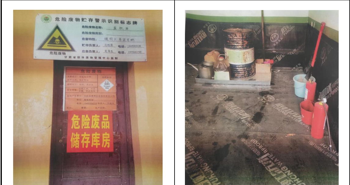
危废暂存间（扁坡电站）
