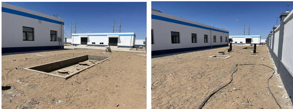
化粪池+一体化污水装置
