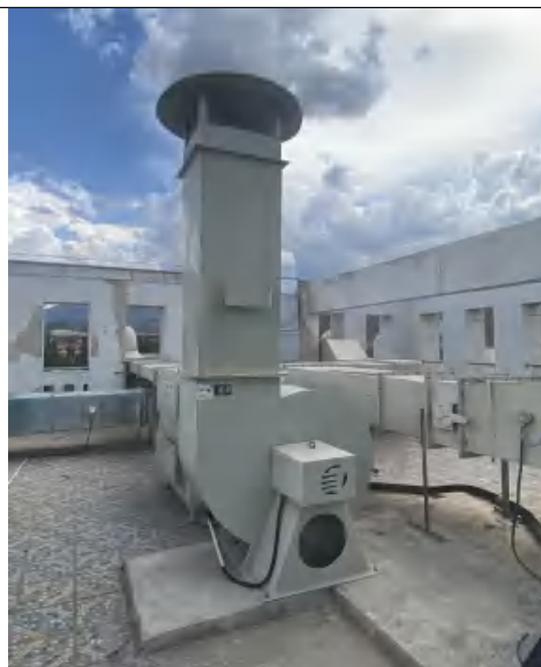
图8 废气处理装置及排放口
