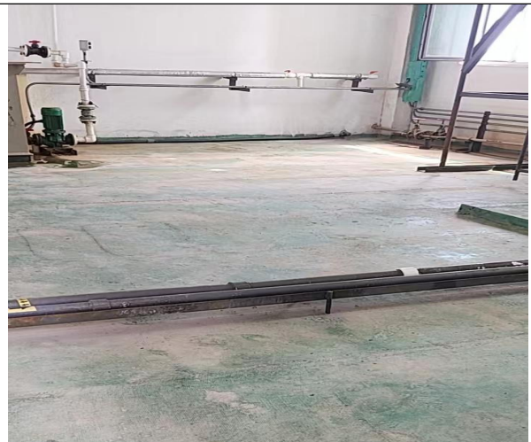
车间环氧树脂防腐
