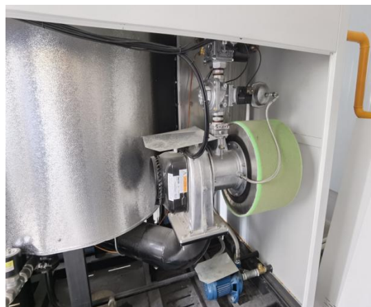
1.2t/h 蒸汽锅炉低氮燃烧器
