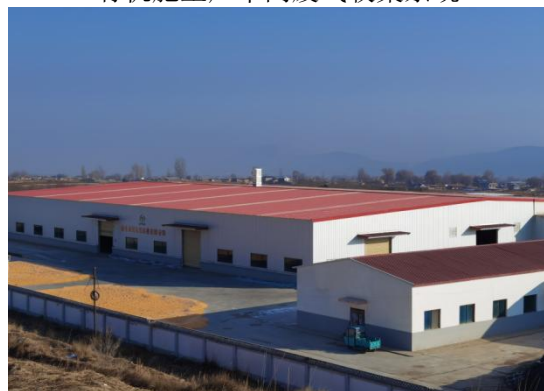
有机肥生产车间废气排气筒
