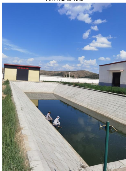
污水处理站蓄水池
