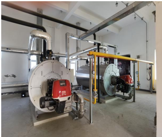
2.1MW 燃气热水锅炉低氮燃烧器+烟气再循环设施+14m 高烟囱
