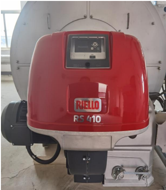
2.1MW 燃气热水锅炉低氮燃烧器
