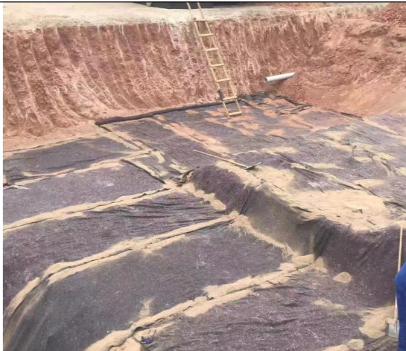
污水罐区防渗
