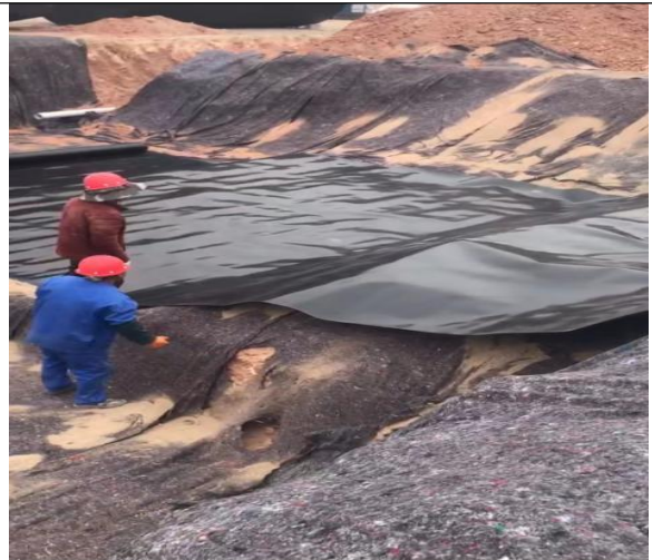
污水处理站防渗
