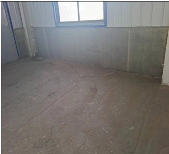
甲类危废暂存库环墙施工完成防渗
