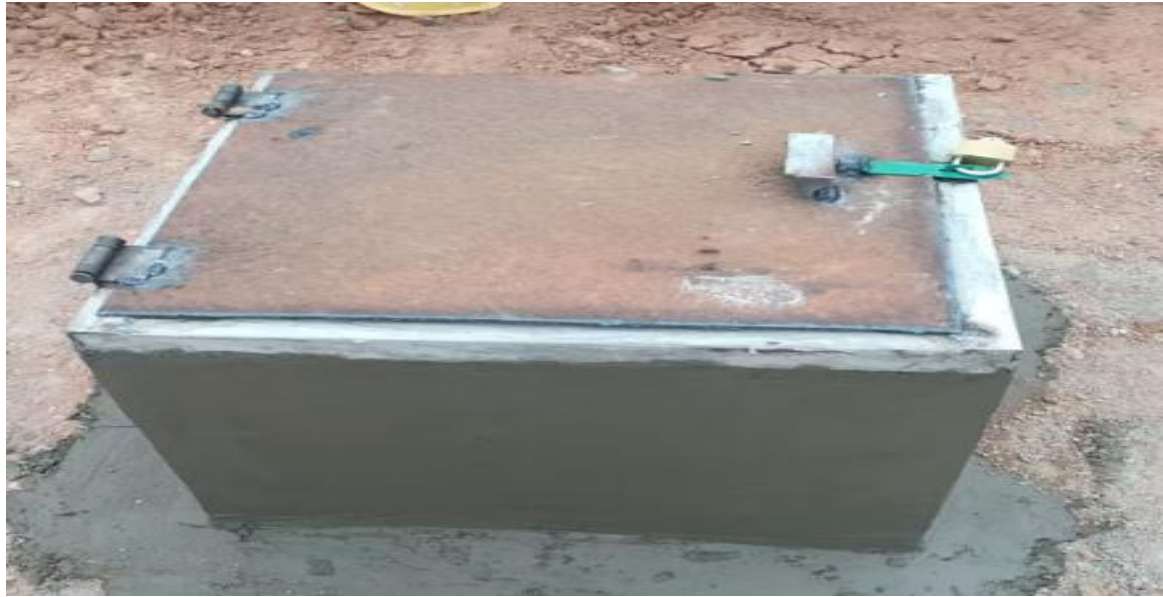
地下水监测井
