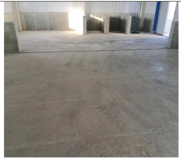
甲类危废暂存库施工完成防渗
