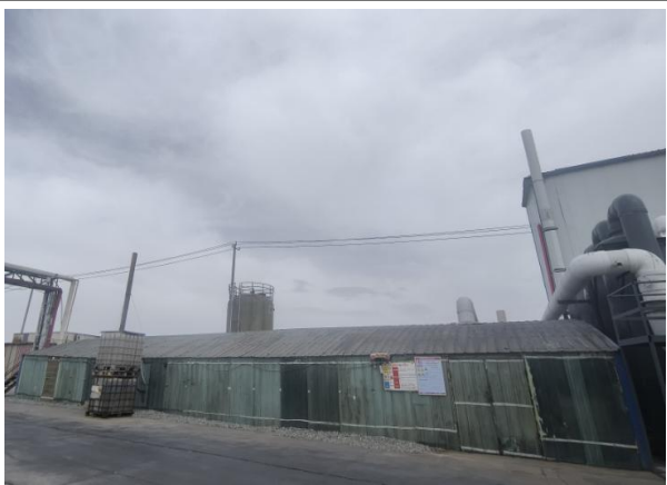
污水处理站主体工程全景图
