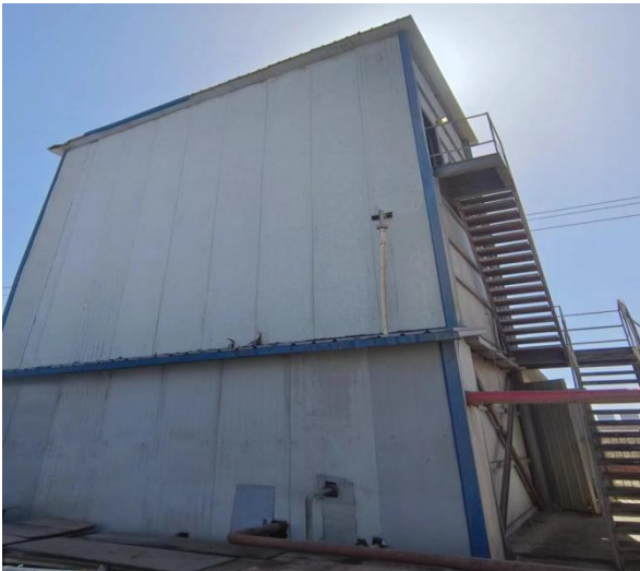
三效蒸发装置
