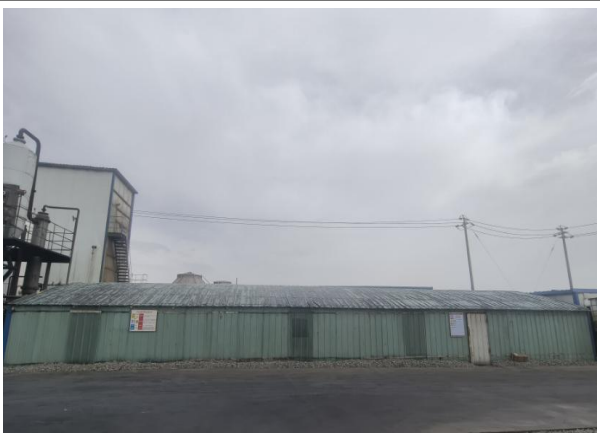
污水处理站主体工程全景图
