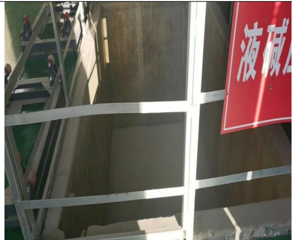
液碱施工完成防渗
