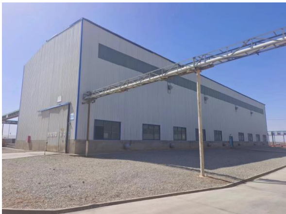
生产车间主体工程全景图
