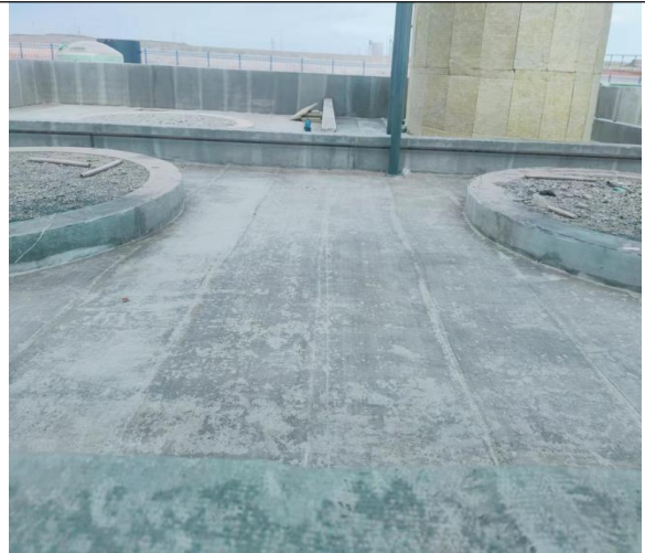
罐区施工防渗
