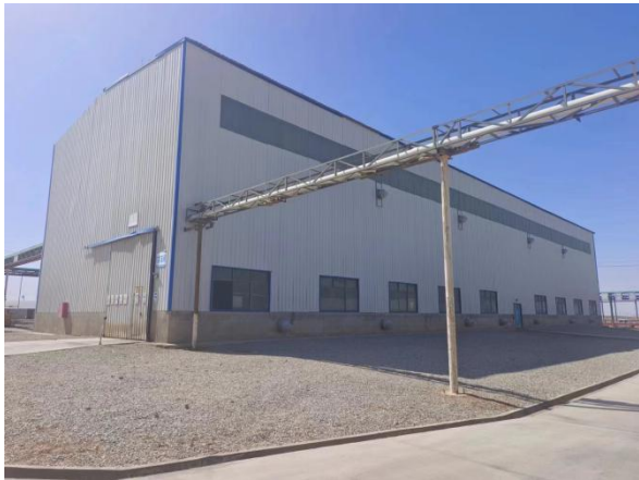
生产车间主体工程全景图
