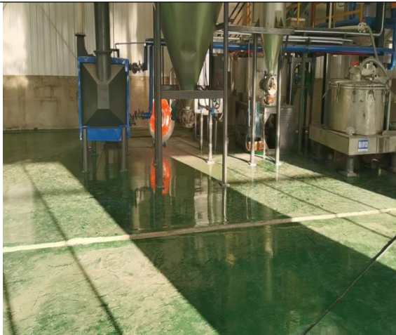
1#车间施工完成防渗
