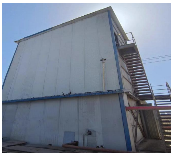
三效蒸发装置
