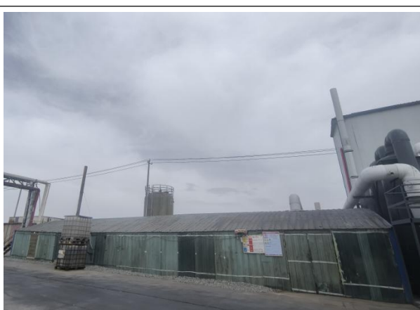
污水处理站主体工程全景图
