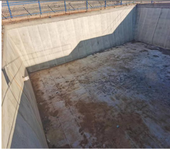
事故应急池施工防渗
