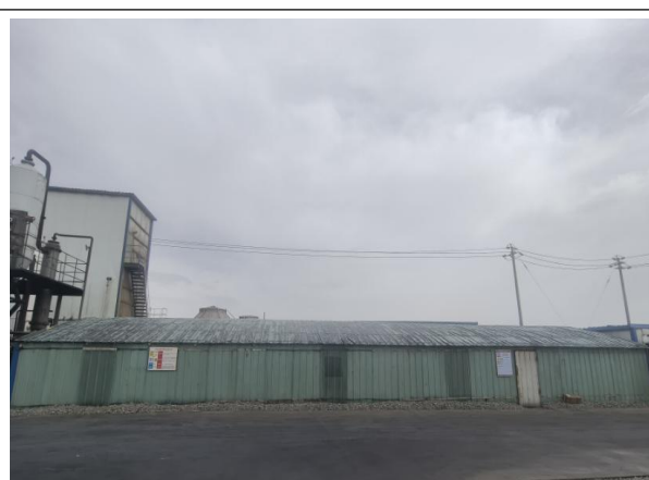
污水处理站主体工程全景图
