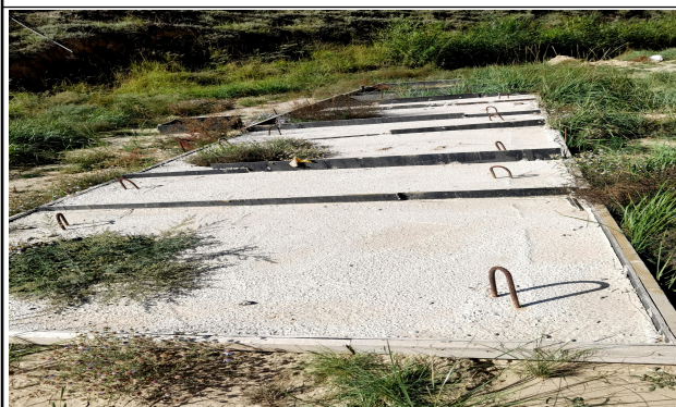
混凝土闸阀井
