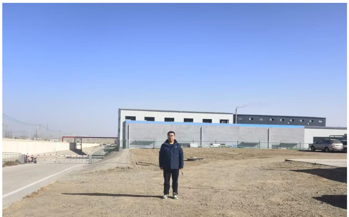
现场踏勘照片
