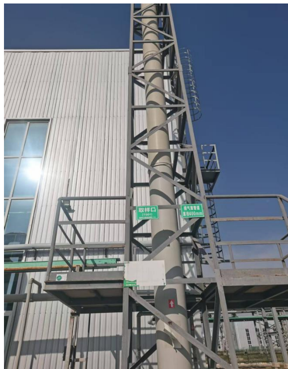
污水处理站、危废库房废气排放口（DA002）
