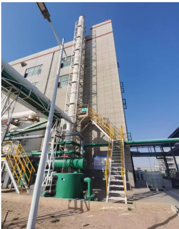
污水处理站、危废库房废气排放口（DA002）
