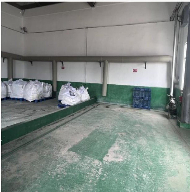
危废仓库导流槽、收集井、分区隔档
