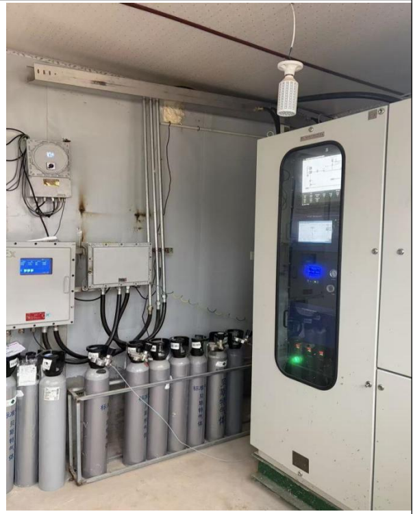
废气在线监测设备
