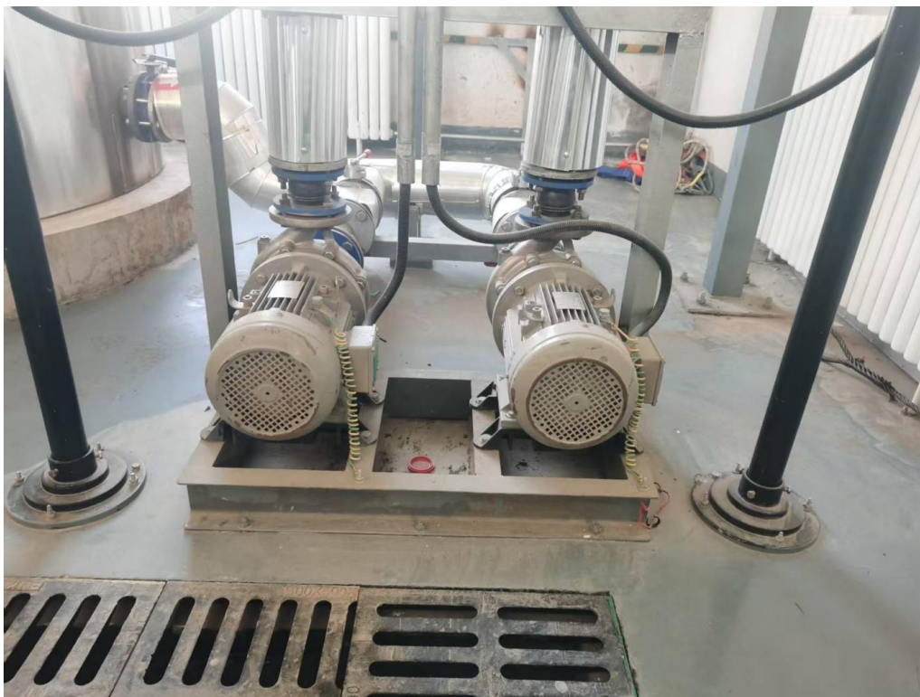
车间机泵设置基础减震
