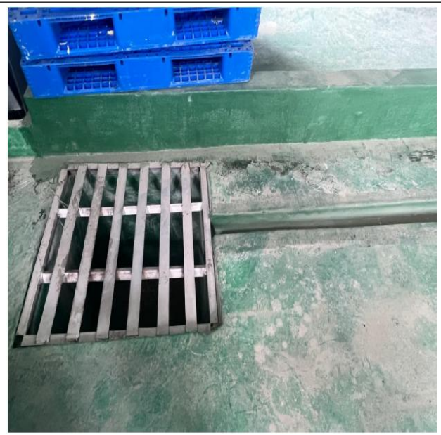
危废仓库导流槽、收集井、分区隔档
