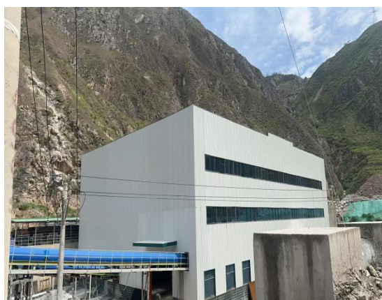
制砂车间（外部）
