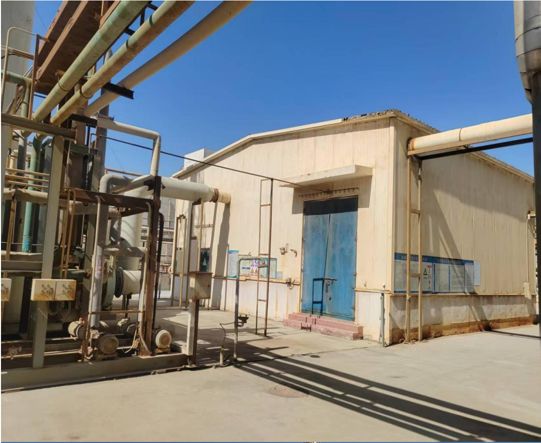
13.液氯库房照片
